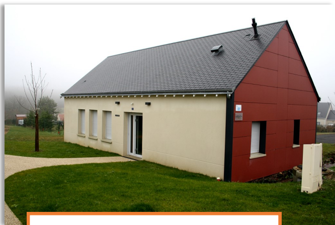
Façade Avant - Entrée principale
