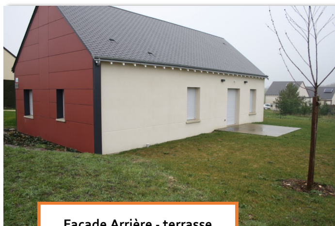
Façade Arrière - terrasse
