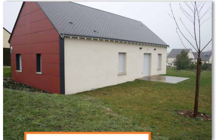
Façade Arrière - terrasse
